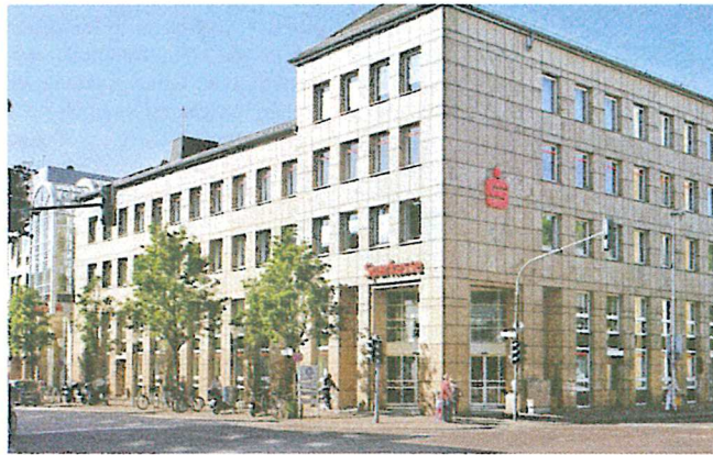
Die Sparkasse Düren gehört zu den 70 Gebäuden, die MeteoViva bislang mit ihrer innovativen Steuerung optimiert hat. Foto: Sparkasse Düren
